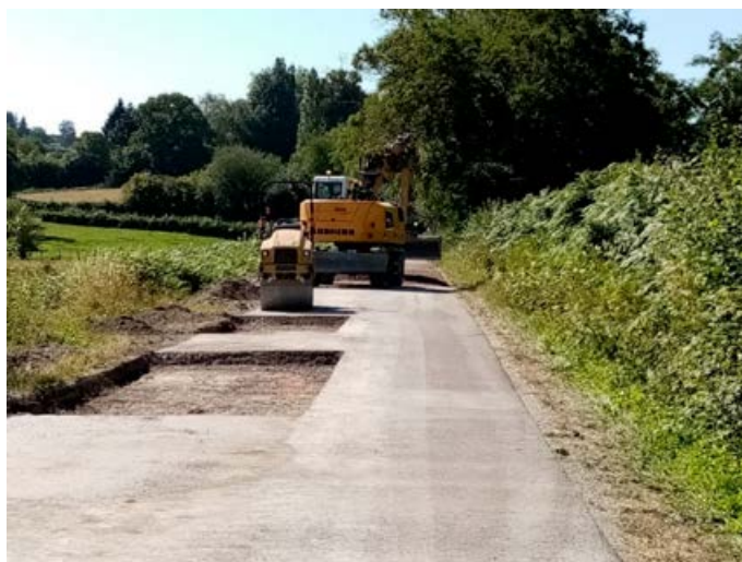
Exemples de traitement de la structure de chaussée : Purge
