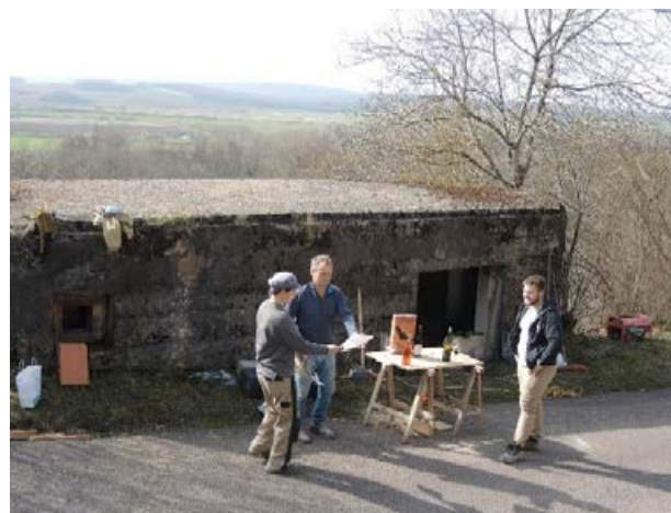
Travaux d'aménagement d'un blockhaus pour les chauves-souris à Cravant
